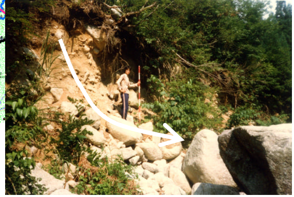
崩落した三光川溪流内
