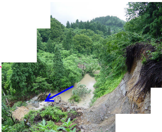
法面崩壊により棚橋川へ土砂流入(平成17年6月)
