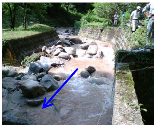
集中豪雨により上流から巨礫が押し寄せる(平成17年8月)
