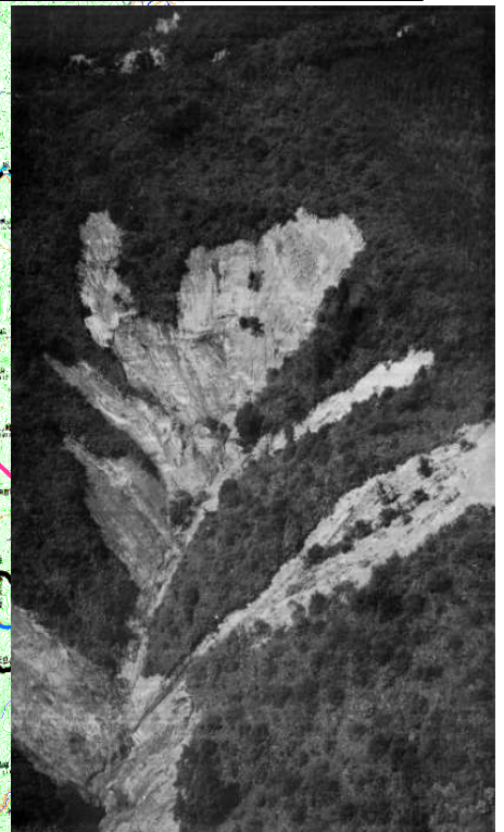
坪穴集落裏山の崩壊状況
