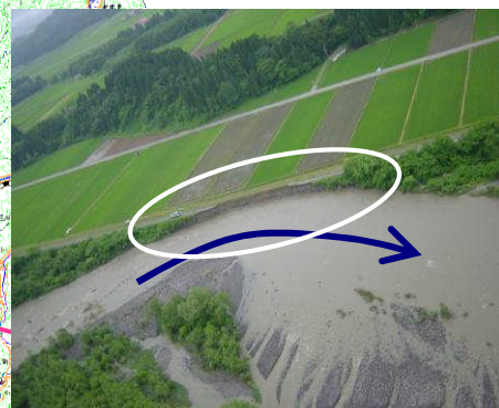
胎内川左岸堤防欠損 (平成17年6月)
