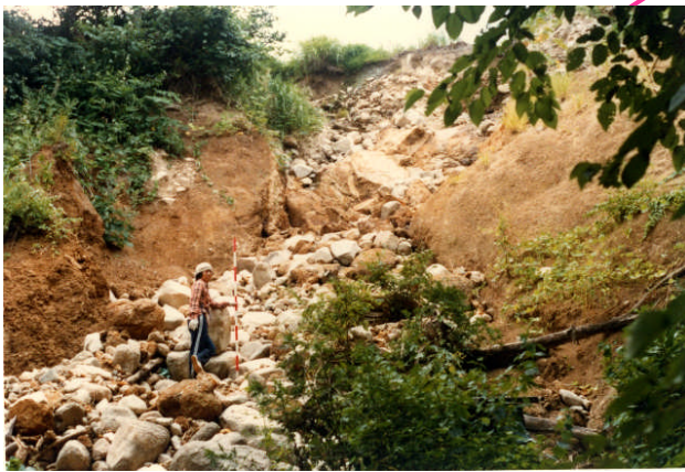
崩落の痕跡(加治川支流)
