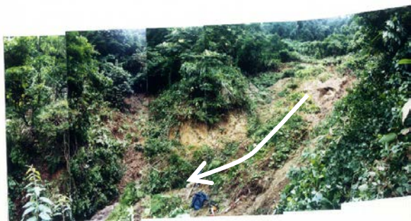
崩落した横山沢溪流(平成10年8月)
