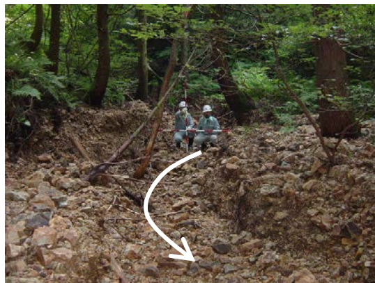
豪雨により溪流内で土砂流出 (平成16年7月)
